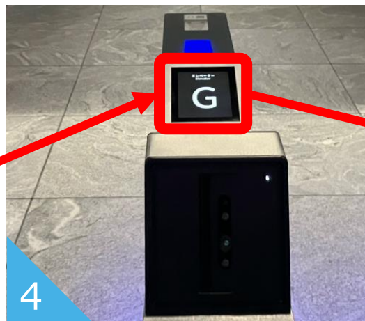
赤枠にエレベーター番号 (A～H)が表示
